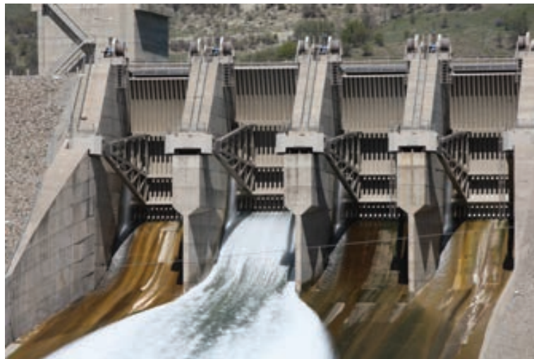
Energía producida en hidroeléctricas.
