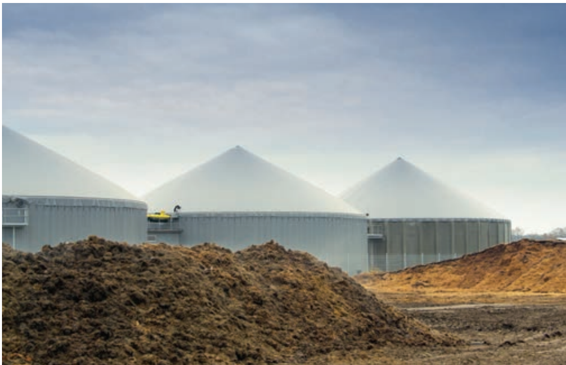
Planta de Biogás.
