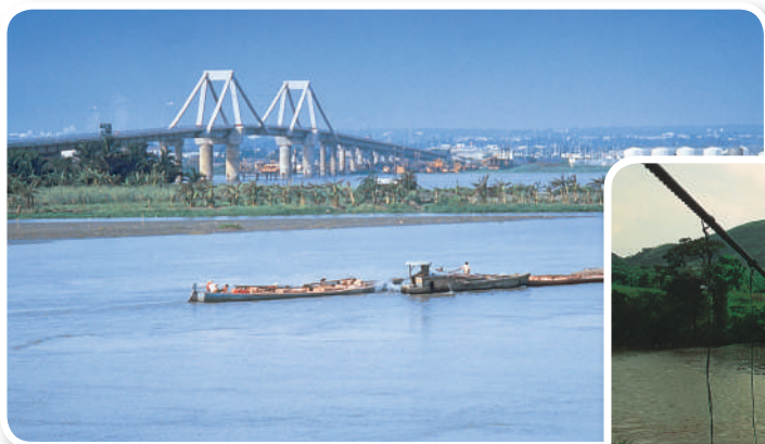
El puente Pumarejo sobre el río Magdalena en Barranquilla.
